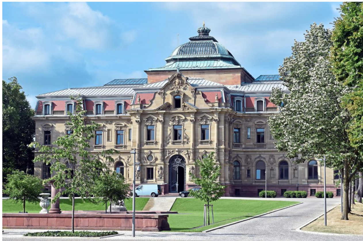
Bundesgerichtshof: Hat die Gelegenheit verstreichen lassen, seine Rechtsprechung zu korrigieren.
